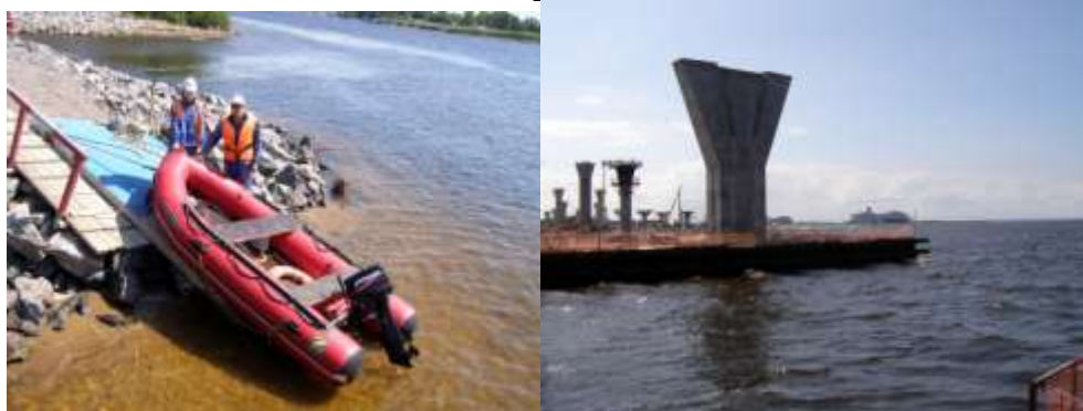
Рис. Обеспечение безопасности при строительстве ЗСД
